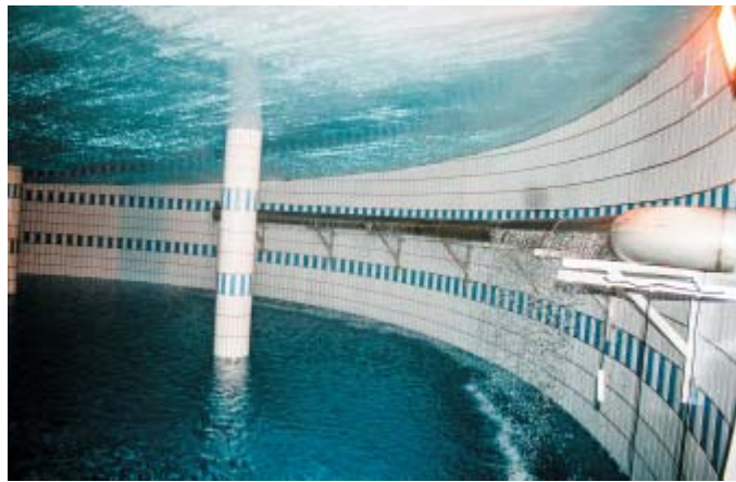
Sauberes Wasser: Der Hochbehälter am Beverunger Eisberg versorgt mit täglich 900 Kubikmetern Trinkwasser die Kernstadt sowie Wehrden und Drenke.
